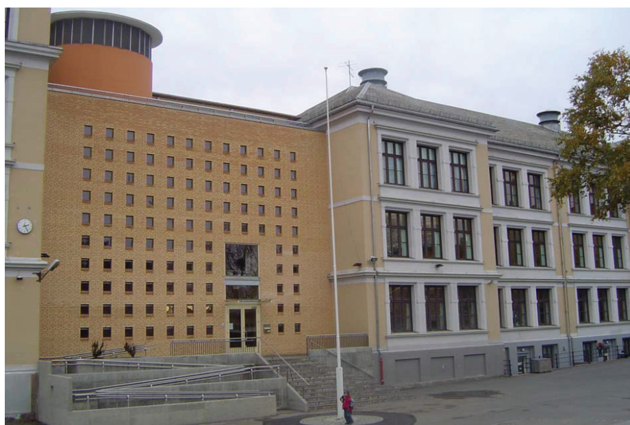
Kampen skole med nytt mellombygg med integrert luftinntak. Foto: SINTEF Byggforsk
