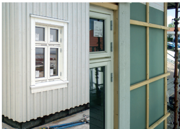
Fig. 1. Lektekledning montert på sløyfer og lekter
