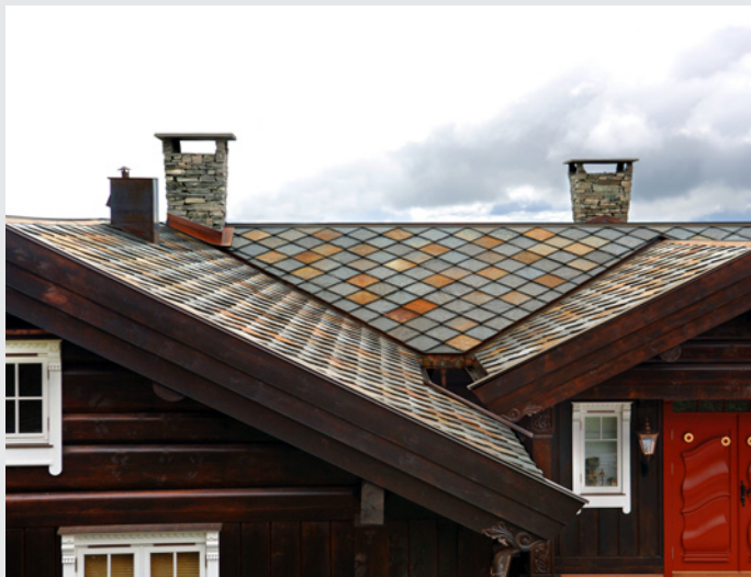
Nyere tak belagt med Ottaskifer. Foto: Minera Norge AS.
