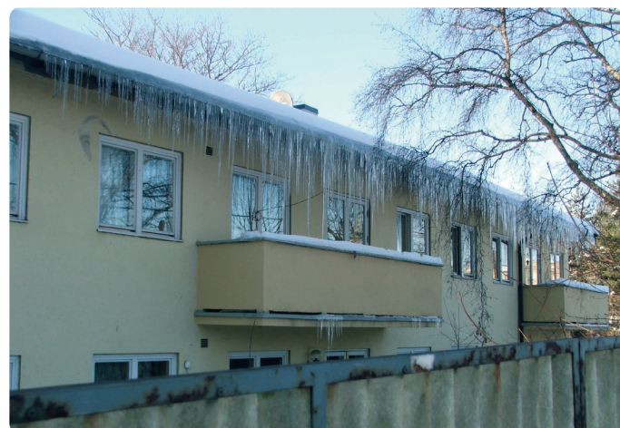
▲ Isdannelse ved takfoten kan demme opp vann slik at lekkasjer oppstår (Trehus, fig. 10.3.3)
