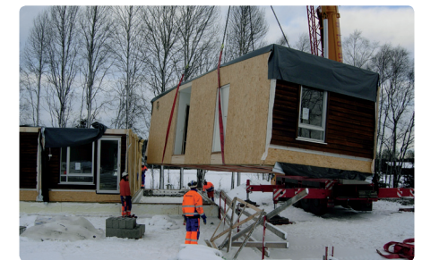
Fig. 4. Montasje av moduler til en moderne boligblokk
