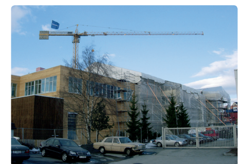
Fig. 6. Skolebygg i Trondheim under oppføring under full værbeskyttelse
