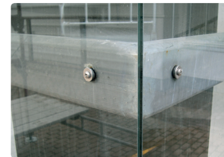
▲ Herdet glass med boltinnfesting i trappeoppgang. Til venstre: vertikale glasskanter i direkte nærkontakt. Til høyre: et glass på samme sted har knust og falt ned.
