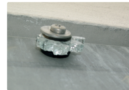
▲ Herdet glass med boltinnfesting i trappeoppgang. Til venstre: vertikale glasskanter i direkte nærkontakt. Til høyre: et glass på samme sted har knust og falt ned.
