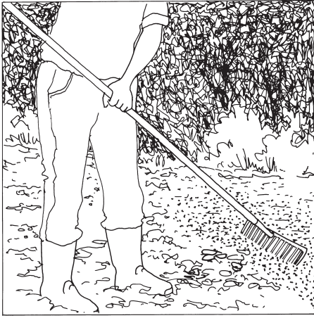
Fig. 37 Etter løysning av grunnen, jevnes overflaten med jernrive før vekstjordlaget legges på (pkt. 38).
