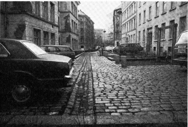
Fig. 27 c Deichmans gate etter/under opparbeidelse (Foto: Tom Dyring)
