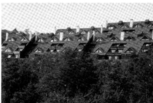
Fig. 31 c Bruk av skråtak kan gi bedre tilpassing til terreng og omgivelser. (Bønes i Fana, Ark. MNAL Øivind Maurseth, Bergen)
