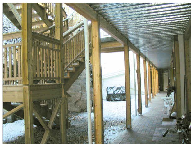
Fig. 4 b Atkomst til svalgang via frittstående trapp i trykkimpregnert tre. Underside av svalgangsgolv er av korrugert stålplate. Foto: Byggforsk
